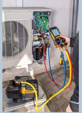
Konfiguration läuft der Evakuierungsprozess also komplett selbstständig.
